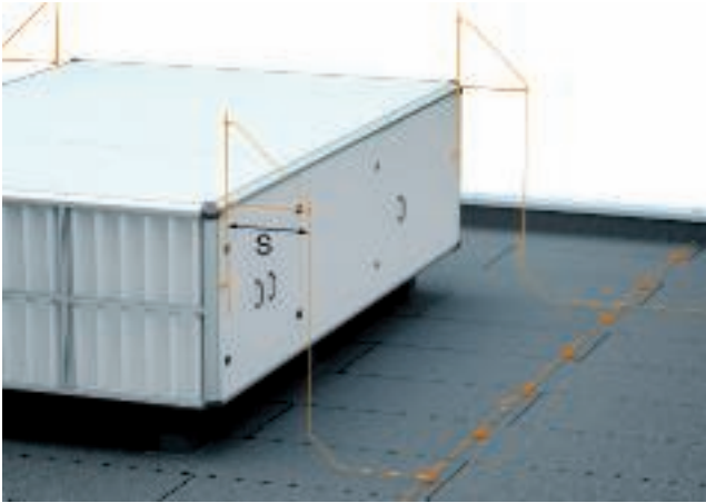
Příklad: Jímací systém s kombinovanou sadou Iso pro trojúhelníkové upevnění
