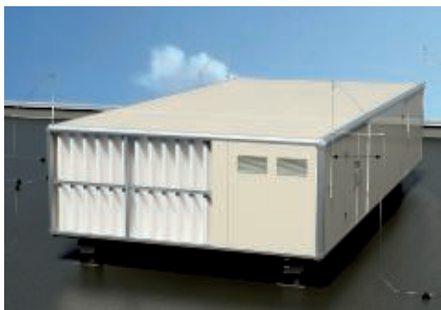
Izolované jímací zařízení s oddělovací vzdáleností (s)
