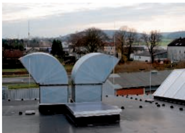
Oddělený systém se sklolaminátovými držáky
