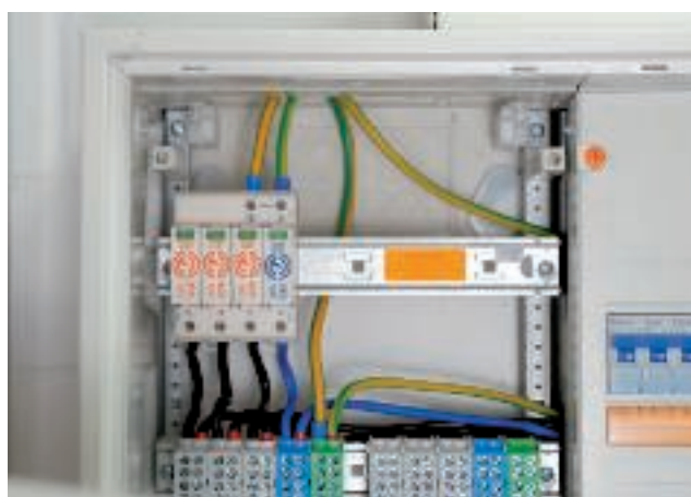
Montáž kombinovaného svodiče typu 1 + 2 V50 v horní části elektroměrové skříň (Německo)
