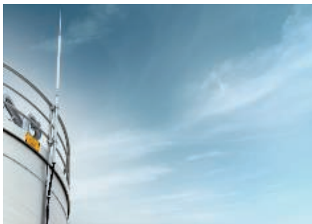
Oddělená ochrana před bleskem s vedením isCon®
