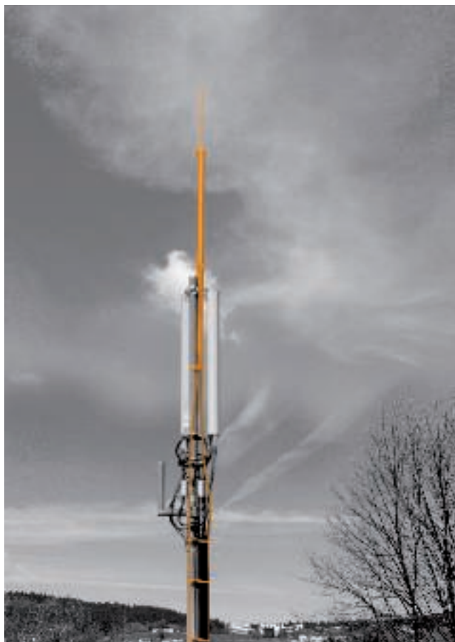
Stožár mobilního operátora se svodem isCon®
